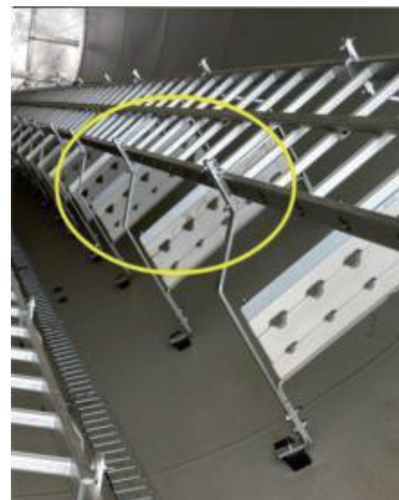
线缆支架固定好后可轻踩磁吸处，注意不要踩在线缆支架外部，力臂太长时，杠杆原理会导致磁吸易松动。
