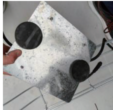
螺杆外露高度必须低于磁吸厚度
